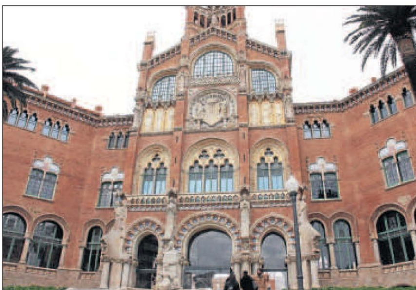
Vista de la façana de l'hospital Sant Pau de Barcelona.
